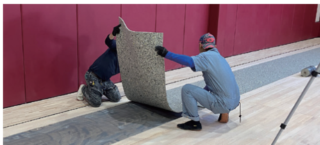
② 接着剤を塗布し適切な所定時間を取り、弾力層を貼り付ける。
