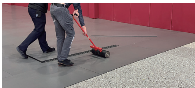
④ 接着剤を安定させる為ローラー転圧を行う。接着剤硬化後、仕上げ工程を行う。
